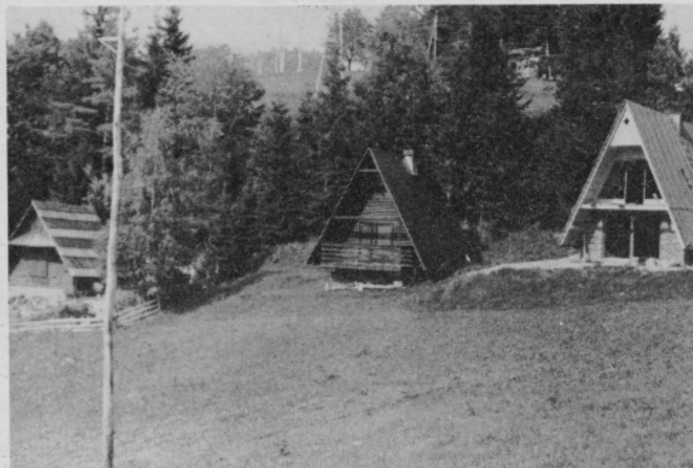
Tu je raj za graditelje vikendov. Odslej bo tovrstna gradnja morala potekati bolj načrtno.
