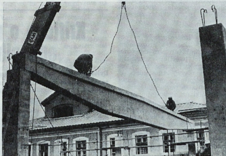
Po odložitvi nosilca delavca odvezujeta pritrdilne vrvi žerjava.
