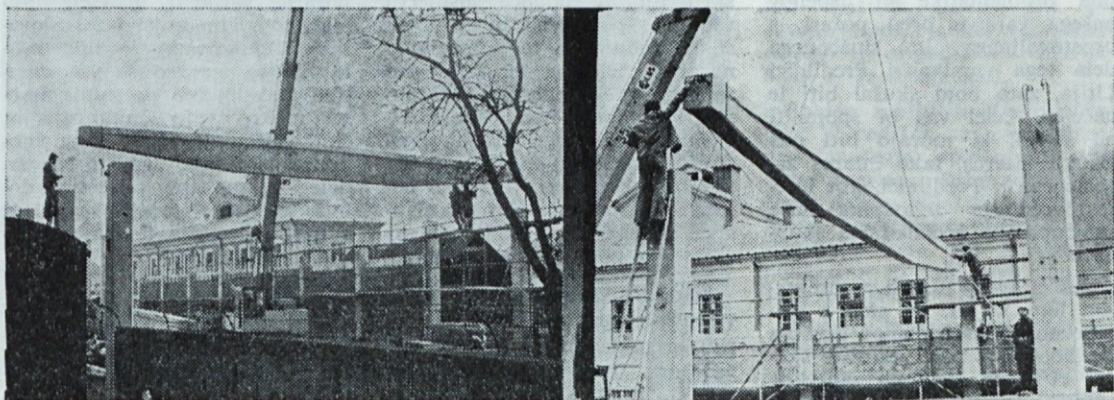
Gradbeni delavci uravnavata strešni nosilec proti stebromu.
