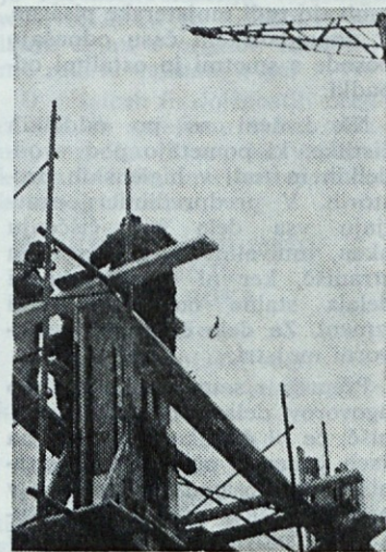
Gradbeni delavci pripravljajo oder in opažne stene z armaturo za betoniranje nosilnih stebrov.
