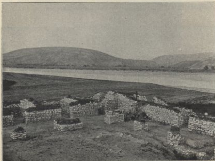
Fig. 10: Die Ostecke des Kastells Mogorjelo mit den Mannschaftskammern und der vorgelegten Pfeilerhalle.
