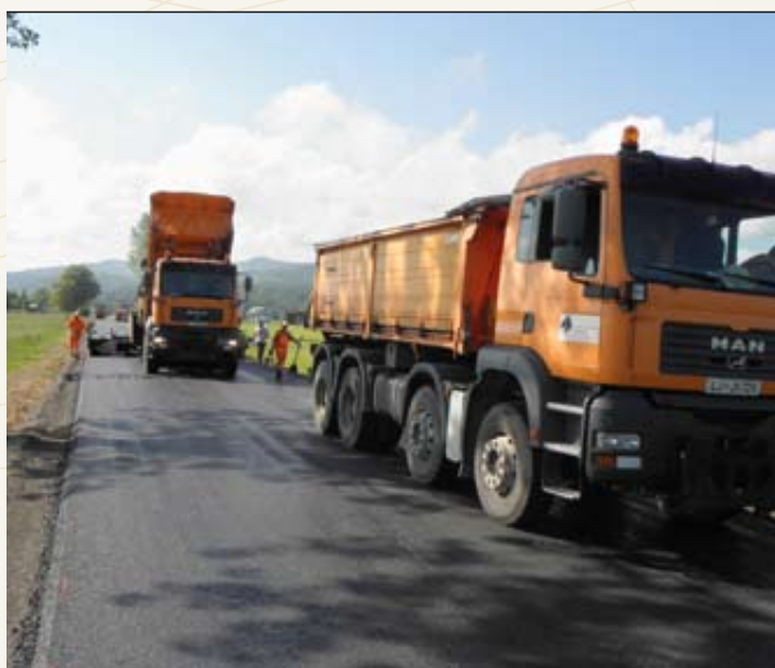
Polaganje obrabne, fine plasti asfalta
