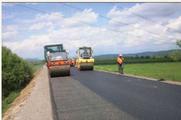
Utrjevanje asfaltne prevleke z dodajanjem drobnega peska
