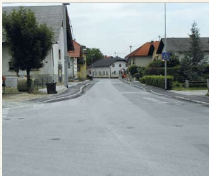
Novozgrajeni pločnik na Ljubljanski cesti s svetlobno označitvijo prehoda za pešce
