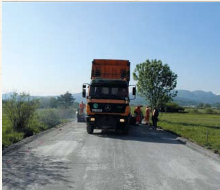
Polaganje nosilne, grobe plasti asfalta
