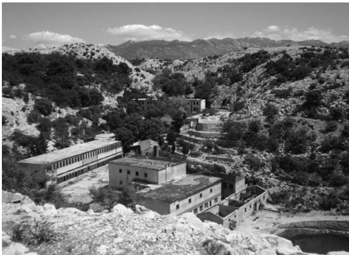
Pogled na kuhinjo in stavbo, kjer so spali zaporniki.
