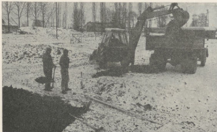
Izkop prvih kubičnih metrov zemlje za nove SERVICE
