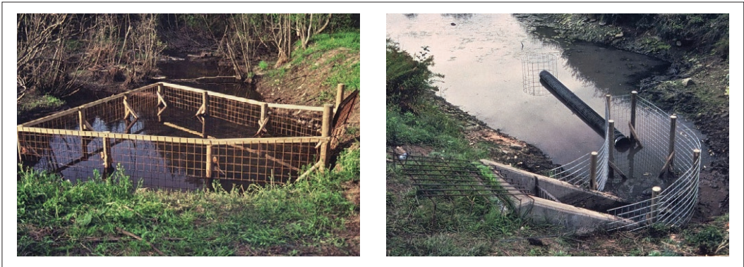
Slika 12: Levo Beaver deceiver™ in desno kombinacija s sistemom Castor master™ (foto: S Lisle)
