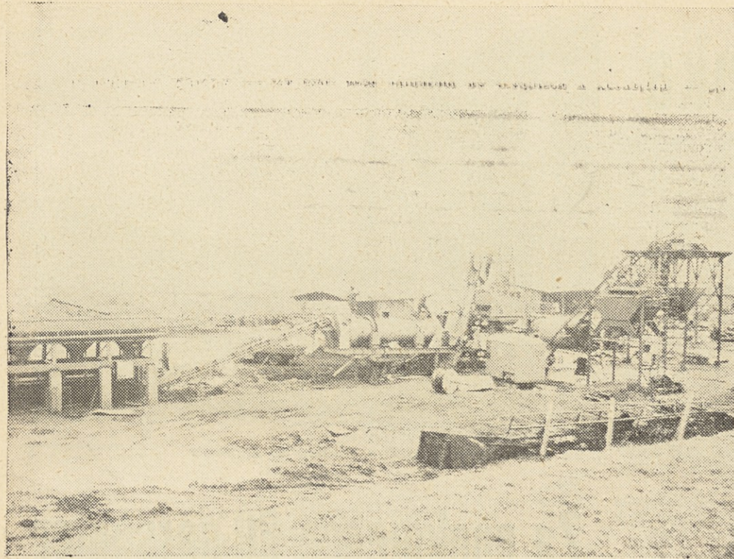
IZ KOVINSKIH OBRATOV V MARIBORU. — Na levi: Z montažne asfaltne baze v Zagrebu za podjetje »Put«. — Na desni: Montaža sušilnega bobna. Na sliki sta Stanko Smoliš in Oto Grobelnik
