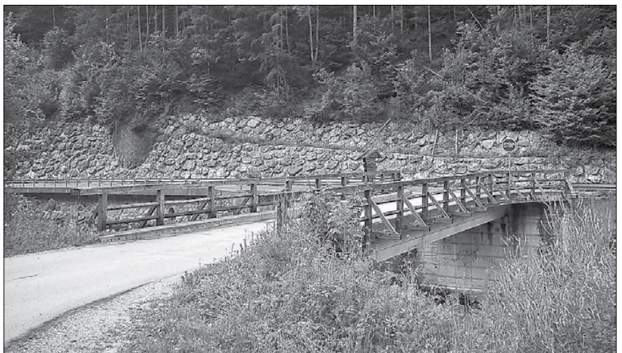
Po več kot 80 leti je tam sedaj nov betonski most, asfaltiran in brez sredinskega podpornega stebra, a s podobno leseno ograjo. (Foto: IS)
