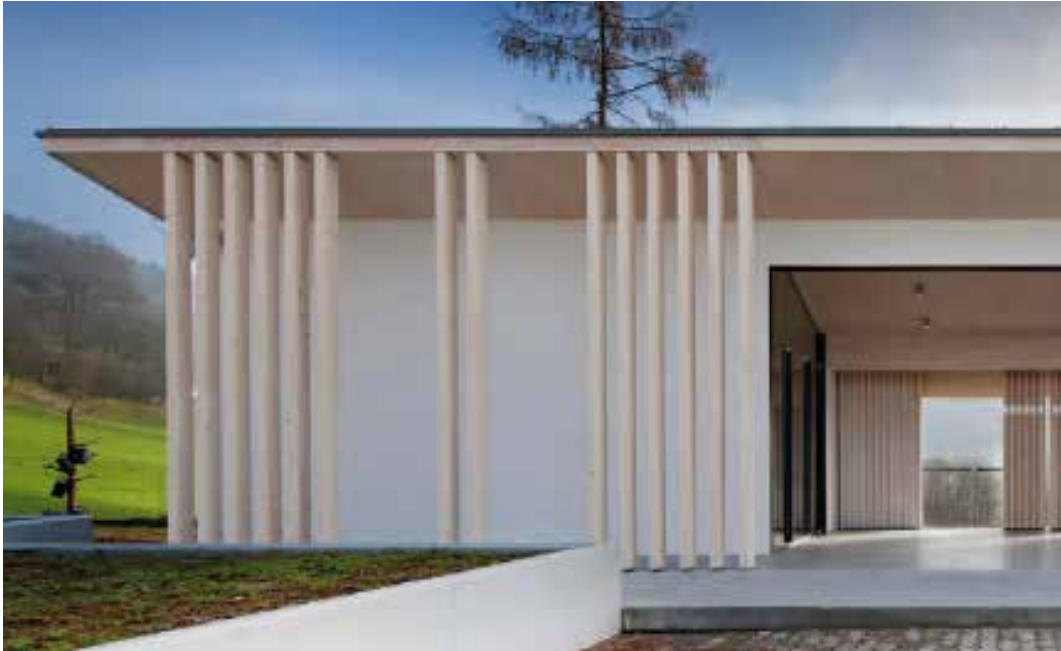
Slika 6: Poslovilni objekt, Zg. Tuhinj (2014), arhitektura: Jernej Hočevar, Matevž Vrhovnik, Martin Lovrečič, Blaž Česka, Tjaša Justin (vir: https://outsider.si/poslovilni-objekt-v-zg-tuhinju/ ).
