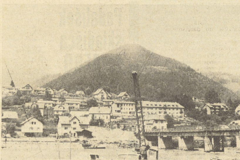
ZGORAJ: Novi most v Dravogradu bo dolg 216 metrov in bo grajen v železobetonski konstrukciji s prednapetimi nosilci
