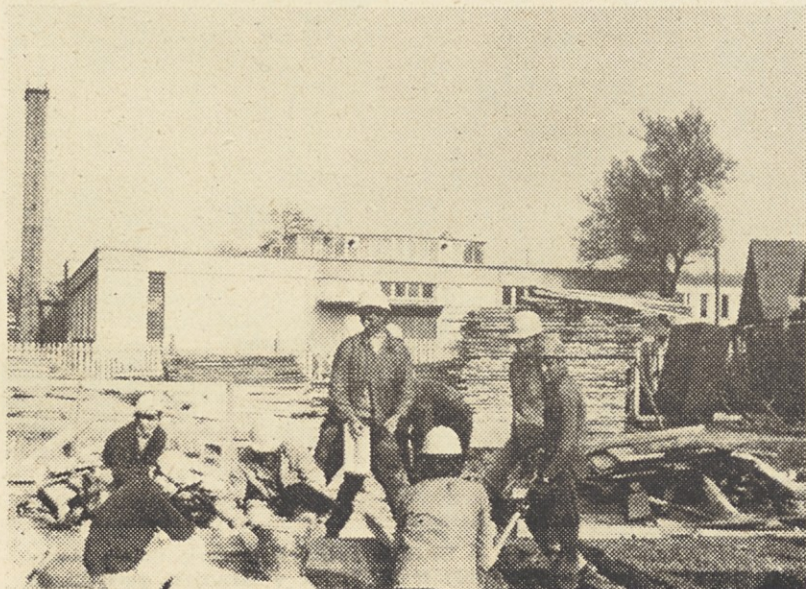
Tako pa na gradbišču. Delati moramo pa vsi
