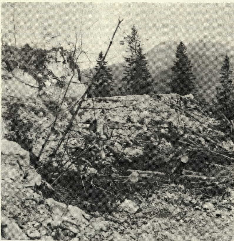
Posledice slabega sodelovanja med gozdarji in gradbeniki
