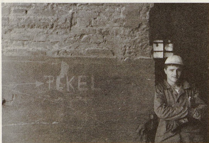
Vhod v elektrolizo A
