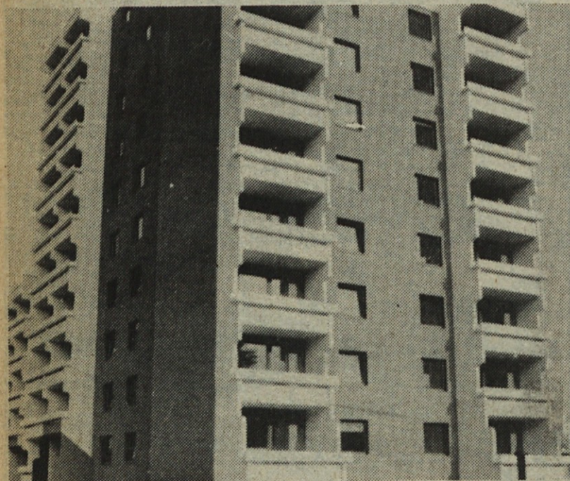
Stolpnica na Javorniku je končana in predana uporabnikom. To je eden zadnjih objektov v stanovanjski soseski Javornik na Ravnah
