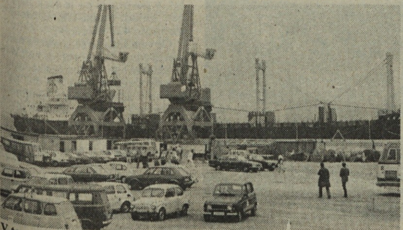
V terminalu je vgrajeno 6000 kubikov betona, 1400 ton armatur, skupna dolžina pilotov pa je 11 kilometrov. Ob terminalu bodo lahko pristajale ladje z 80.000 tonami nosilnosti
