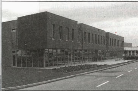
Nova upravna stavba Komunalnega podjetja v Puhovi ulici. Foto: Janko Bohak
