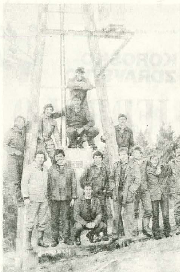
Ko so delavci Elektra Slovenj Gradec na Završah postavili trafo postajo, so se za spomin še slikali, foto F. Jurač
