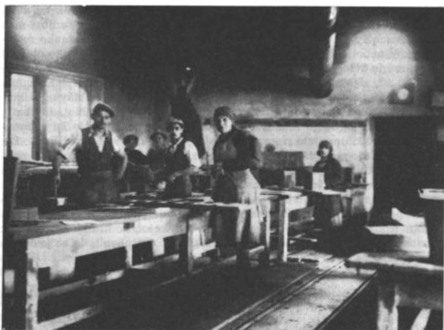
Nizke mezde, nezdravo delovno okolje in odklanjanje kolektivne pogodbe so glavni vzroki, ki so prisilili delavce šamotarne v Štorah, da so začeli stavkati. — Del obrata (oblikovalnica); v ospredju Angela Ulaga, članica stavkovnega odbora februarja 1935
