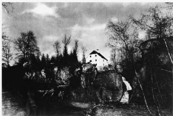
Sl. 1: Marof (Mrzlo Polje). Pogled na slap Gračnice in stavbo v kateri je bil vzidan marmorni spomenik (posnetek iz časa pred približno sto leti, foto F. Jurkovič).
