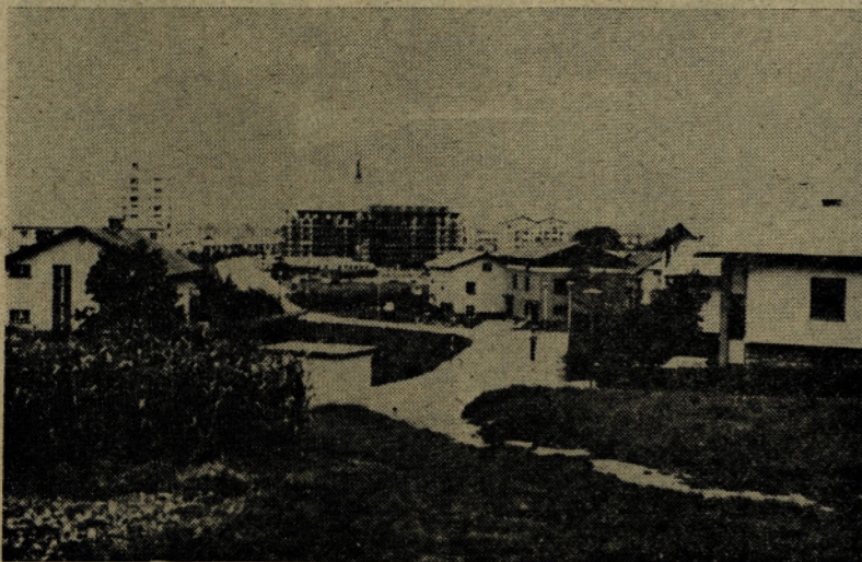
Del hudinjskega naselja kjer predvidevajo gradnjo novih objektov
