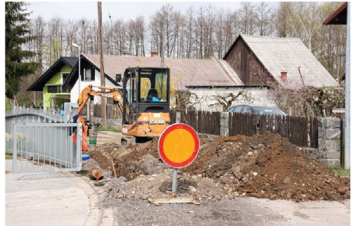
Gradnja pobreške kanalizacije ...
