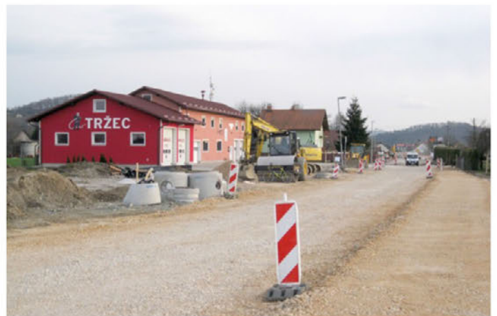
Gradnja nove vzporedne ceste ob gasilskem domu Tržec
