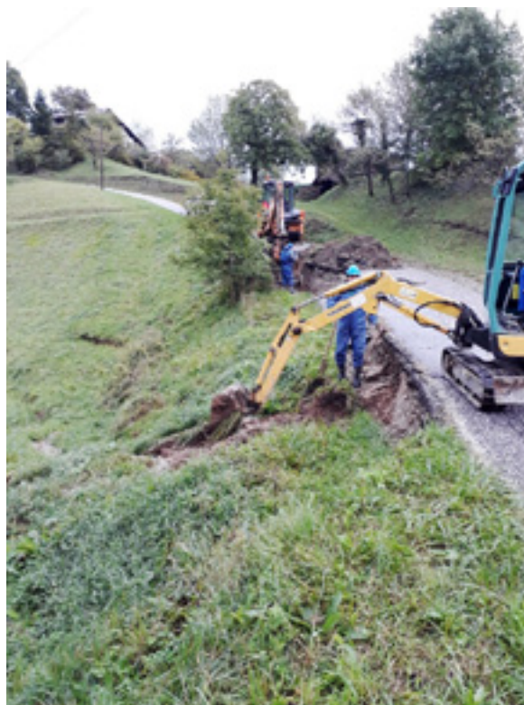
Sanacija vodovodnega omrežja na usadu lokalne ceste LC 102121-Medribnik-Pohorje.
