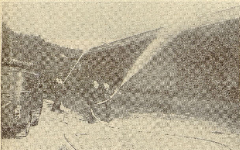
Gasilske enote pri gašenju požara na objektu skladišča
