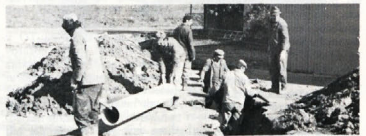
– Komet je moral premestiti kanalizacijske cevi z enega konca delovnih prostorov na drugega, pač, priključiti je moral svoje odplake na čistilno napravo. Škoda, da ni bilo to storjeno že pred leti, ko so bili zgrajeni novi prostori za Komet, saj bi tako ostal v blagajni marsikateri dinarček. Kaj hočemo, včasih je težko načrtovati, težko pogledati nekaj let naprej. (Foto: Janez Zele)
