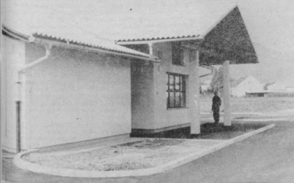
Eden izmed številnih objektov, ki so jih zgradili Kongradovi delavci je tudi nova veterinarska postaja v Slovenskih Konjicah.
