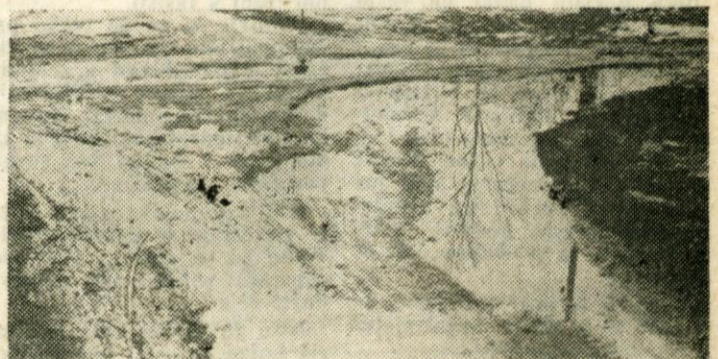
Ljubljanska cesta je v Domžalah edina, ki je sodobno urejena. Cim pa z nje stopimo na stransko ulico, ugotovimo lahko samo to, da je cestišče do konca iztrošeno.
