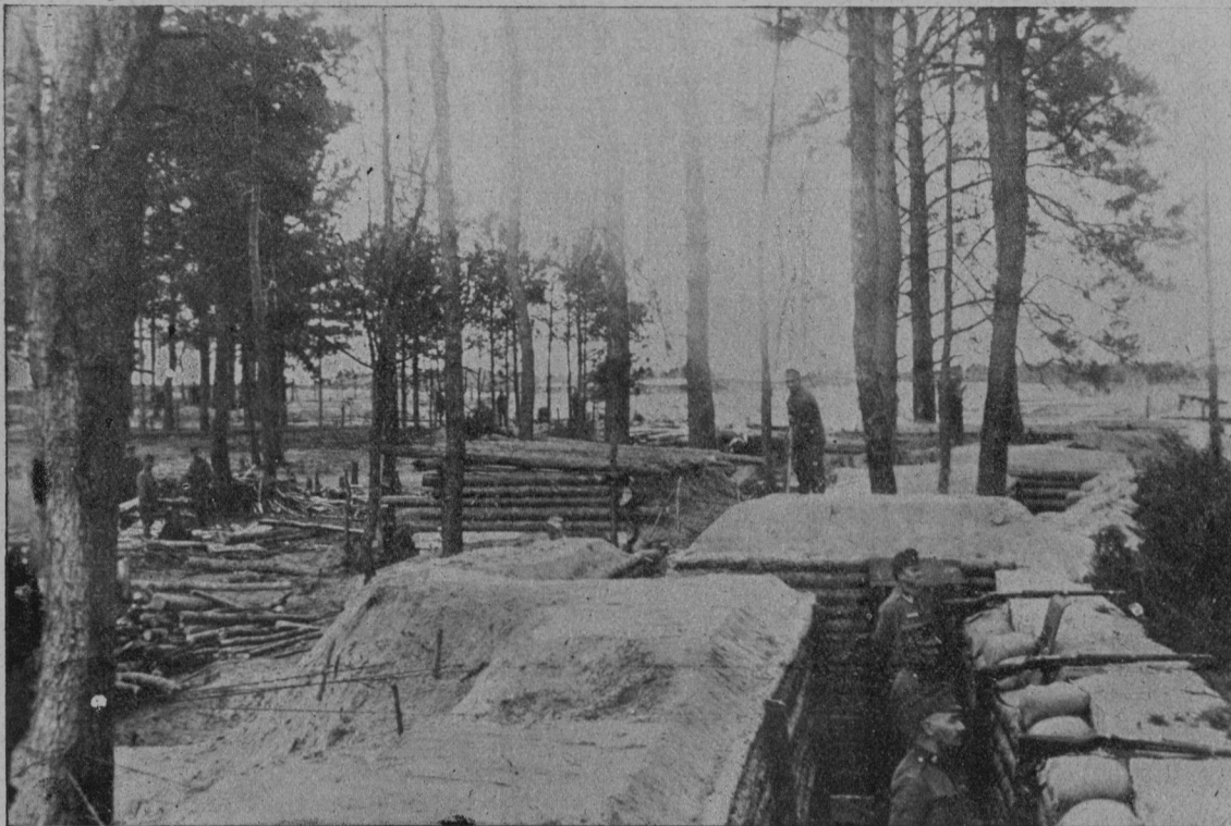
Vzorno zgrajen zakop našega vojaštva ob Strypi na ruski fronti. Beton, vreče s cementom, železo in les delajo zakop nerazrušljiv.
