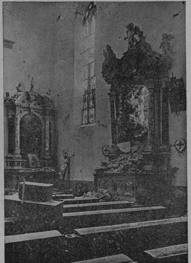
V poškodovani cerkvi Sv. Ivana („Števana“) pri Devinu na Soči.
