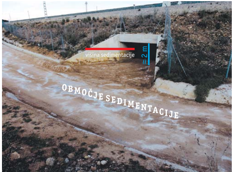
Slika 6: Vodna erozija prsti iz neterasiranega sadovnjaka v španski pokrajini Valencia. Erodirano gradivo je skoraj povsem zasulo železniški podvoz (foto: Matija Zorn).
