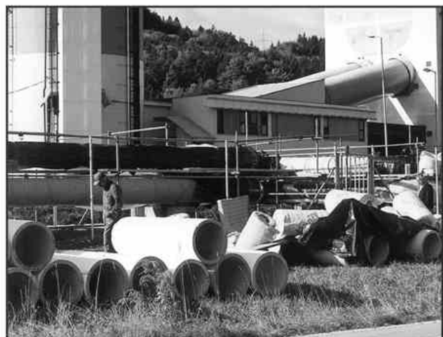
Z zamenjavo dotrajane izolacije nadaljujejo prizadevanja po učinkoviti rabi toplotne energije (foto:vos)
