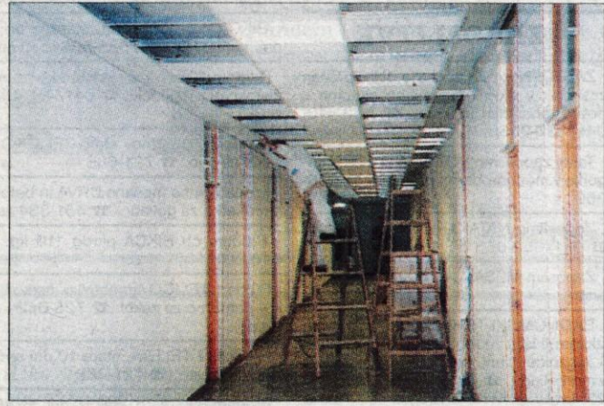
Zamenjava dotrajane električne napeljave v pritličju občinske stavbe, bo občino stala 3 milijone tolarjev.
