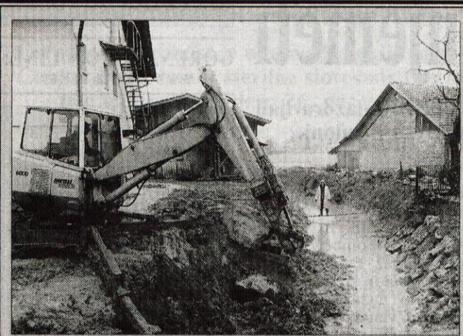
Lahovče, 28. decembra - Ministrstvo za okolje in prostor je glavni financer regulacije potoka Reka skozi najjužnejši vasi občine Cerklje, Lahovče in Vopovlje, občina pa bo primaknila nekaj svojih sredstev za ureditev mostu. V občini Cerklje pričakujejo, da bo regulacija rešila problem poplavljanja, ki v teh vaseh ob vsakem večjem neurju povzroča precejšnjo škodo. Na sliki: regulacija skozi Lahovče. - Foto: Tina Dokl
