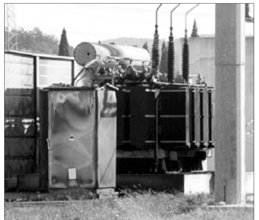
Poškodovani transformator v ulici Colombo
