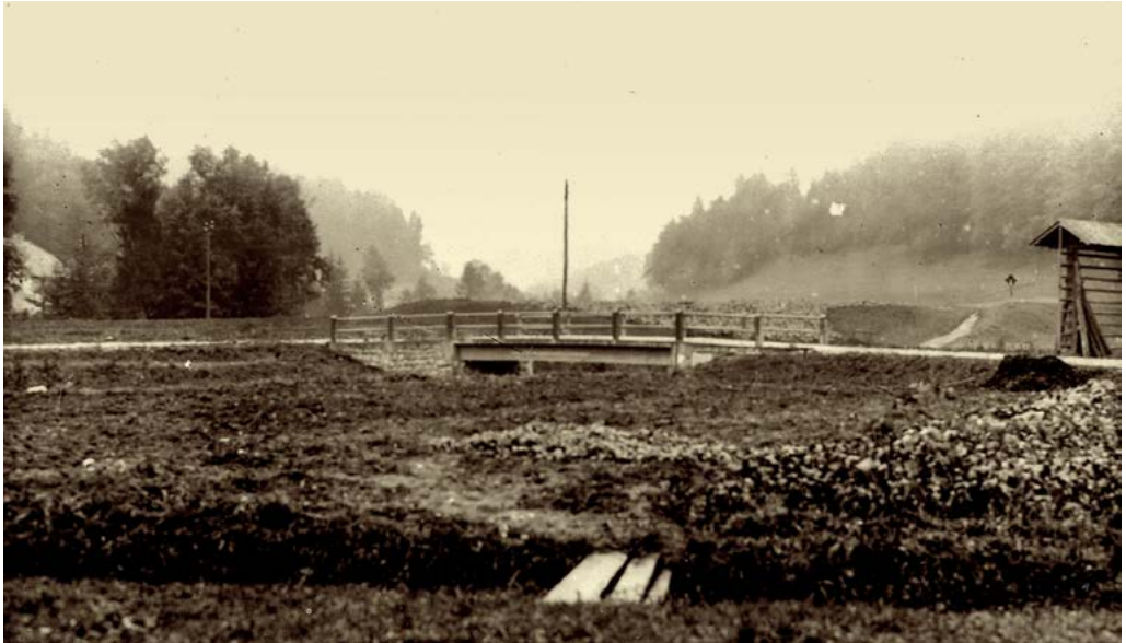
Slika 32: Fotografija, ki jo je Viktor Herfort napravil na najdišču mamuta pri Nevljah po izkopavanju in postavitvi mostu. Fotografijo hrani arhiv PMS.
