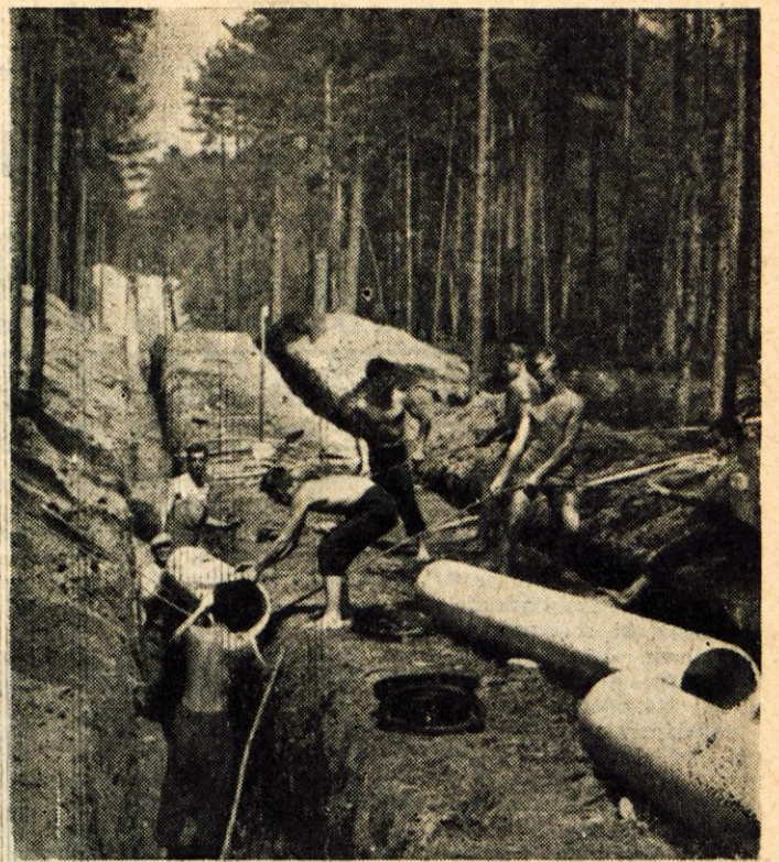
BRIGADIRJI NA SUHI POLAGAJO CEVI ZA VODOVODNO OMREŽJE
