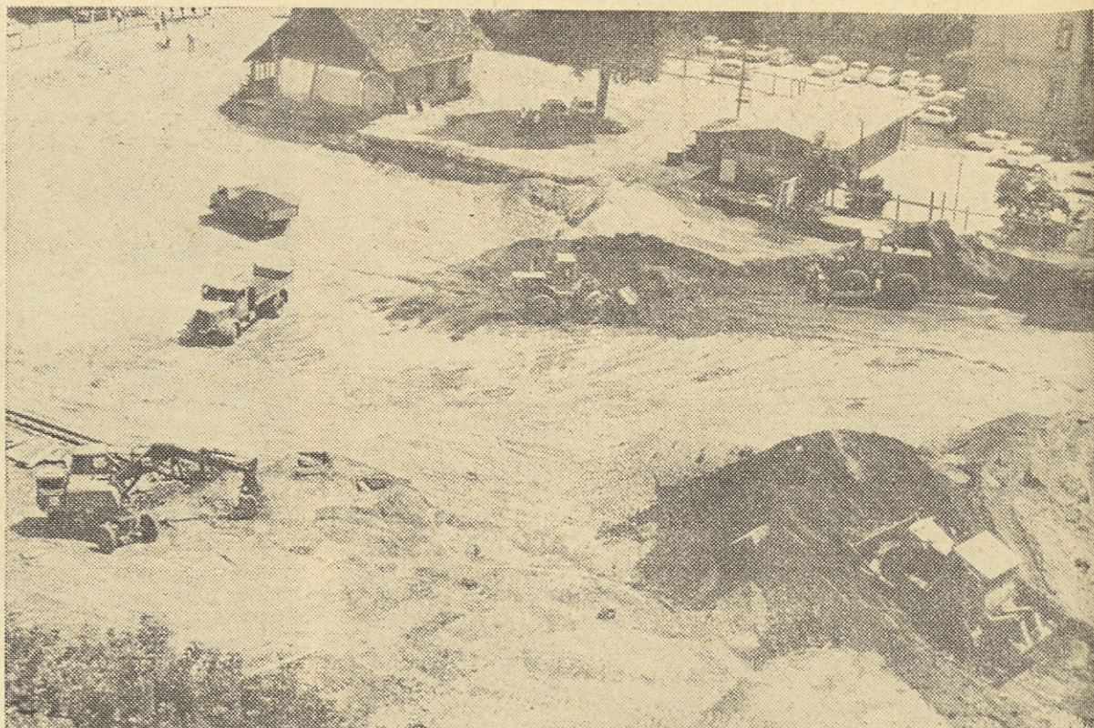
Izkop zemlje na gradbišču novih objektov RTV Ljubljana
