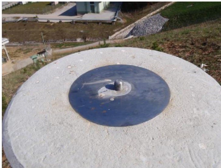
Slika 3.3.1-2: Vijak z ustreznim navojem z zaobljenim vrhom za prisilno centriranje.
