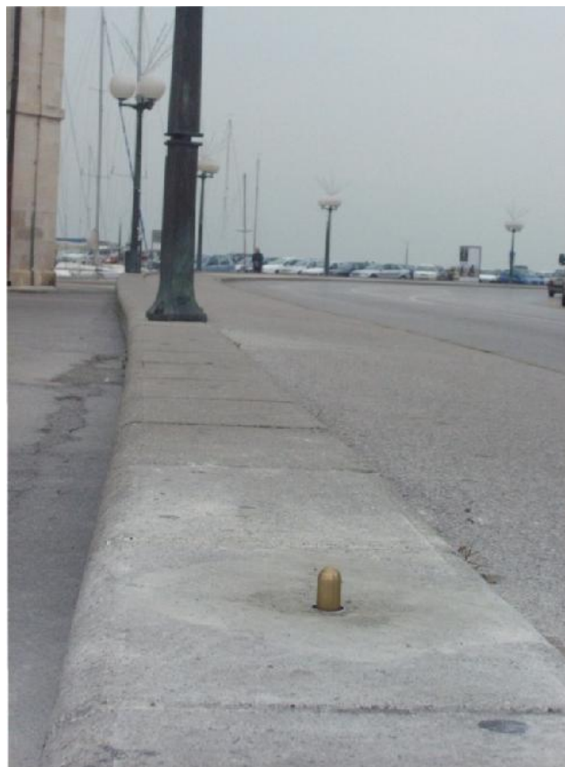
Slika 3.7-2: Nastavek, privit na navoj horizontalne zavarovalne točke.
