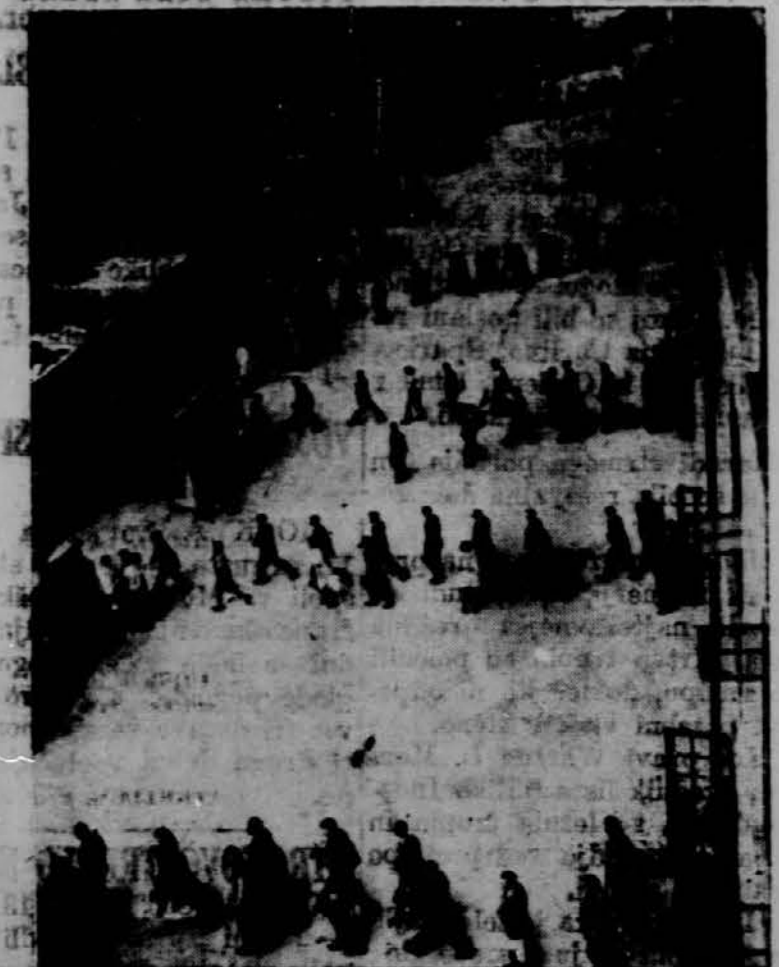
Uslužbeni pri Standard Telephone and Cable Co. v New Southgateu v Angliji gredo med manevri angleške armade z podzemskih prostorov, ki so varni pred zračnimi napadi.
