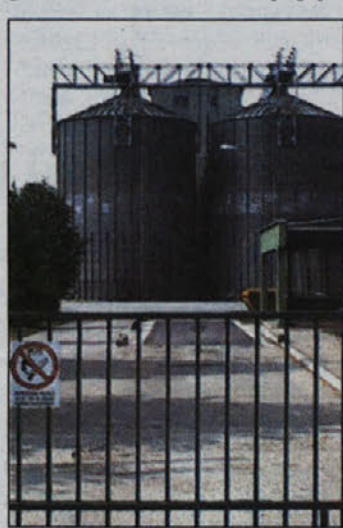
Silos v Brežini čakajo na letošnji pridelek pšenice
