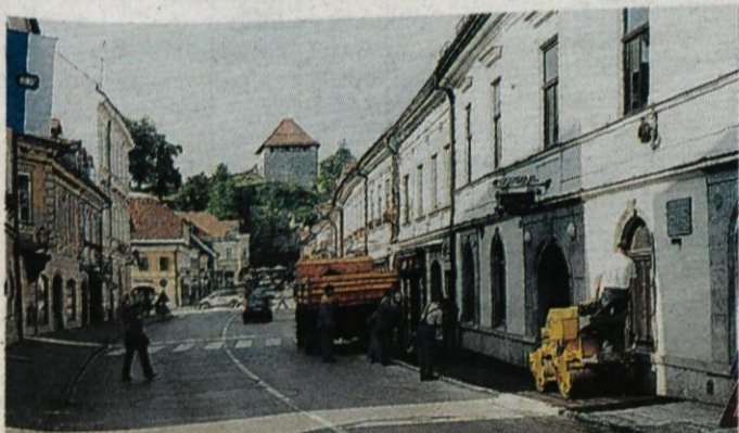
Tudi ureditev cest, pločnikov in ulic je potrebna za kvaliteto bivanja v mestu. Delavci Komunalnega podjetja so v zadnjih tednih uredili kar nekaj cest in pločnikov, med njimi del pločnika na Glavnem trgu pri odcepu proti Franciški samostanu.
