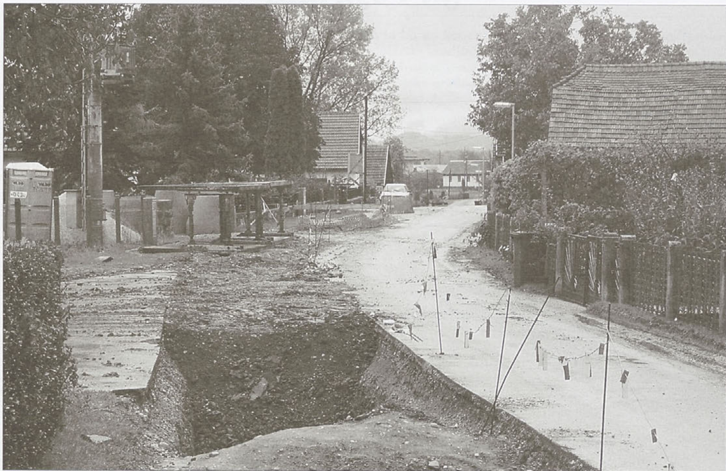
Na Sp. Hajdini se nadaljuje izgradnja kanalizacije na odseku Senekovič - Zupanič.
