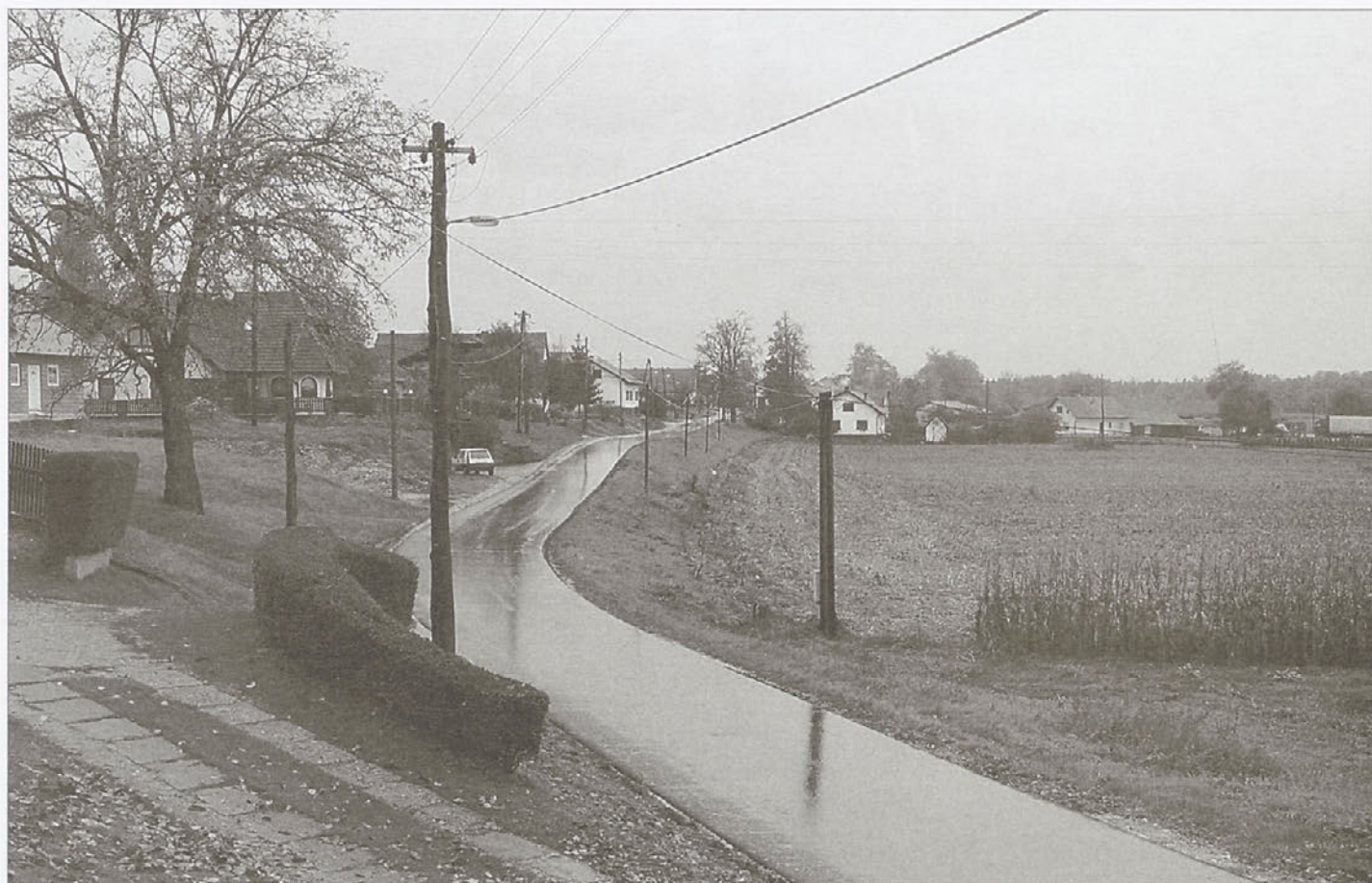
Na Zg. Hajdini je končana preplastitev lokalne ceste - odsek »Školiber - Maja«
