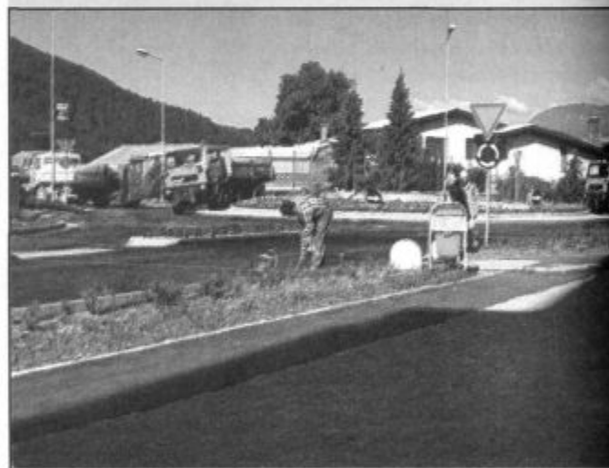
V rondoju so delavci PUP-a (Vegradovi podizvajalci) prejšnji teden polagali fini asfalt.
