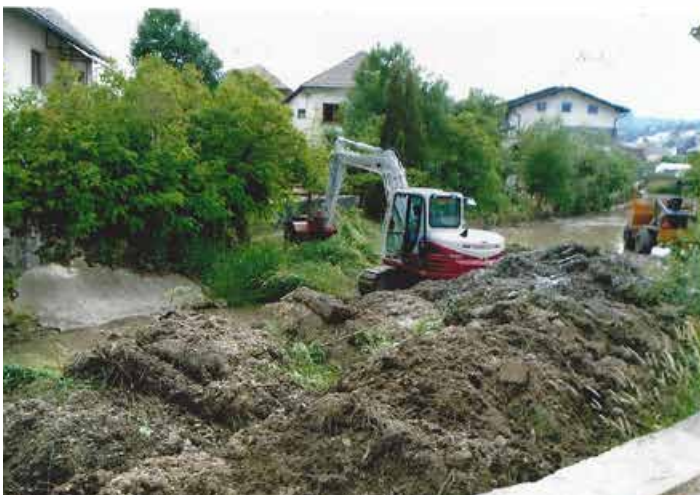
Med izvajanjem čiščenja
