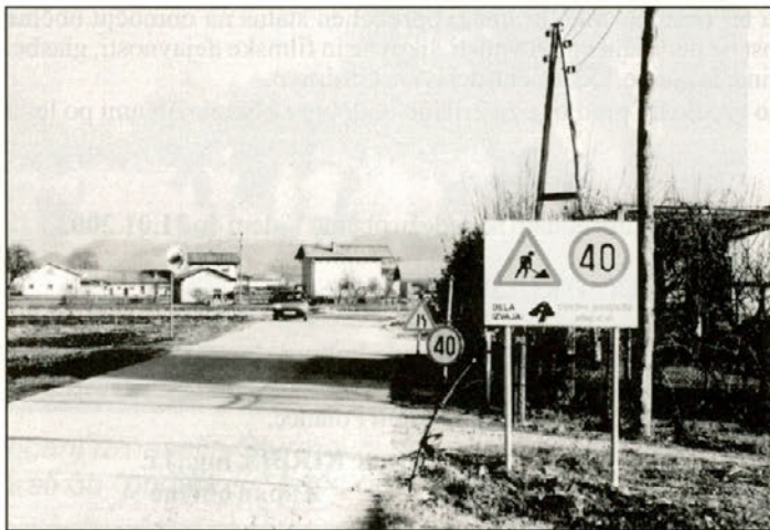
Gradbena dela v Lancovi vasi
