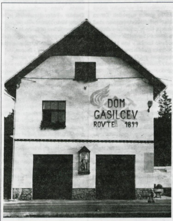
Ozaljšano pročelje rovtarskega doma gasilcev
