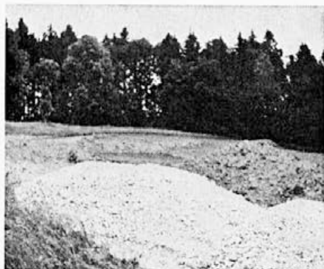
Buldožer je razril zemljo za temelje Foto: F. Modic
