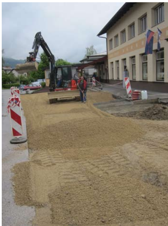
Na parkirišču pred knjižnico Daneta Zajca v Moravčah so odstranjene betonske cevi, ki so motile parkiranje in sam izgled. Urejeno je odvodnjavanje nastreška in položen nov asfalt.
