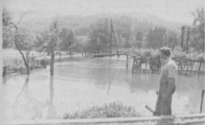
Kljub načrtom pa Dravinja še vedno poplavlja.
