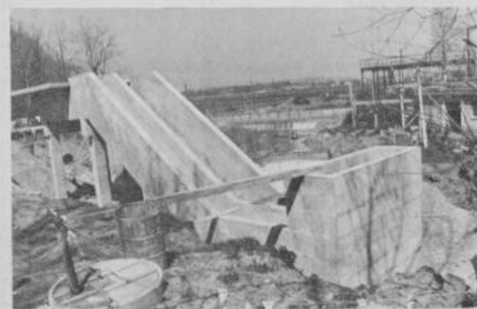
Pogled na gradbišče, v ospredju črpališče za transport gnojnice v zgoščevalne baze.
