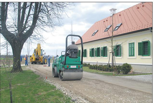
V naseljih Prvenci in Strelci delavci gradbenega podjetja Nizke gradnje iz Ptuja v teh dneh zaključujejo izgradnjo kanalizacije, nato pa bodo razkopane ceste ponovno asfaltirali.
