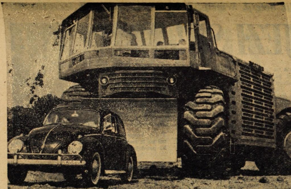
Nekaj taksnega lahko vidite samo v Kansasu. Na sliki je največji stroj na svetu, ki se lahko tudi premika. Dieslov motor oskrbuje preko generatorja električni tok za električne motorje pri kolesih, ki poganjajo ogromna kolesa
