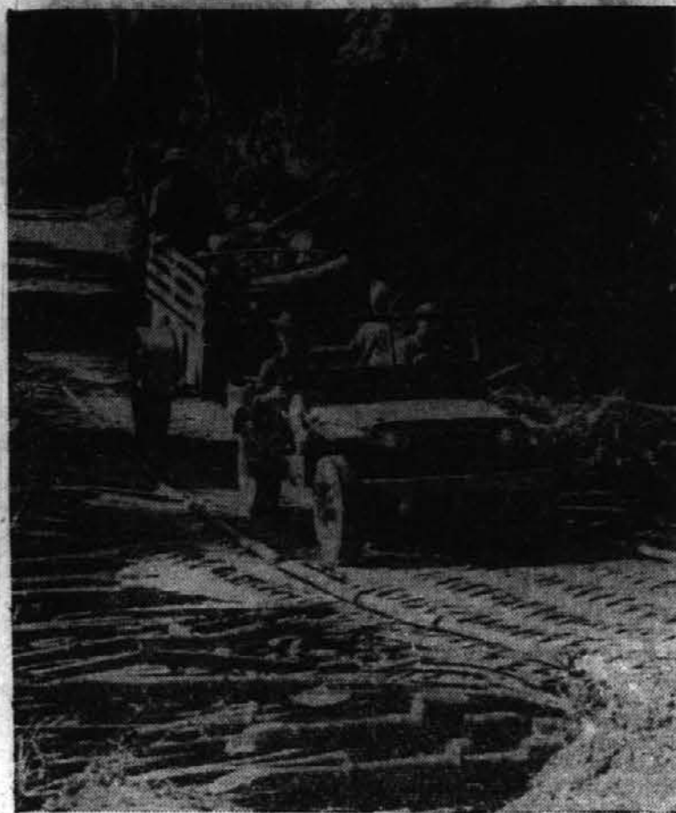
Ameriški vojniki grade po džungli mostove in pota po močvirnatih tleh iz protja. Nasekajo protja in ga nanesejo in razravljajo in na to po njem vozijo z vojaškimi avtomobili.
