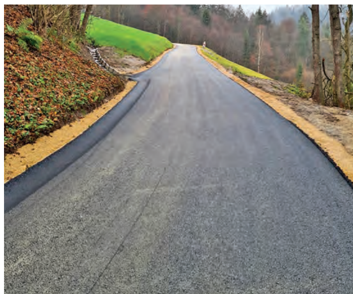
Obnova najbolj poškodovanega odseka na cesti Spodnji Petelinjek–Prevoje.
