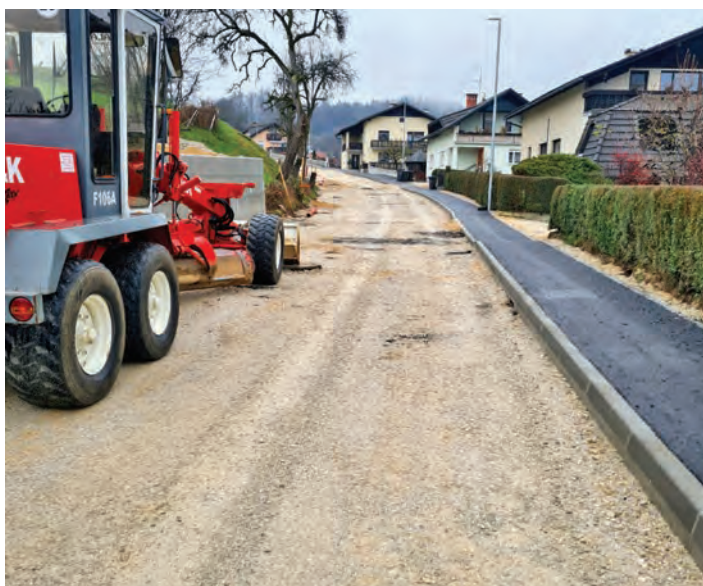
Rekonstrukcije lokalne ceste skozi naselje Rafolče.
