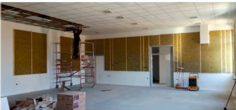
Gradnja godbenega doma
