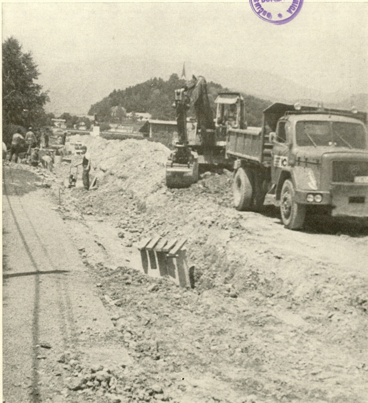
Slika prikazuje zemeljska dela za napeljavo kanalizacijskega voda v neposredni bližini naše delovne organizacije. Na začetku julija je zato cesta od križišča v Preserjah proti Homcu kazala takšno podobo.
